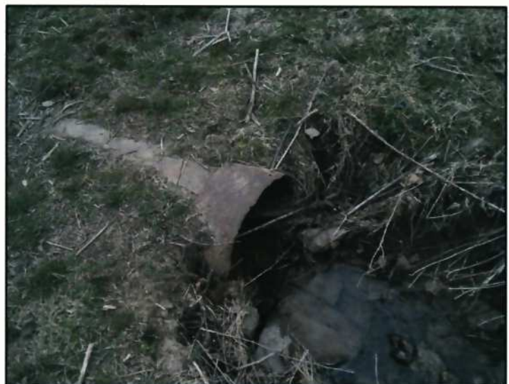
20) 12" SMP culvert entrance
