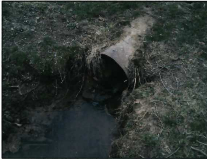
21) 12" SMP culvert exit
